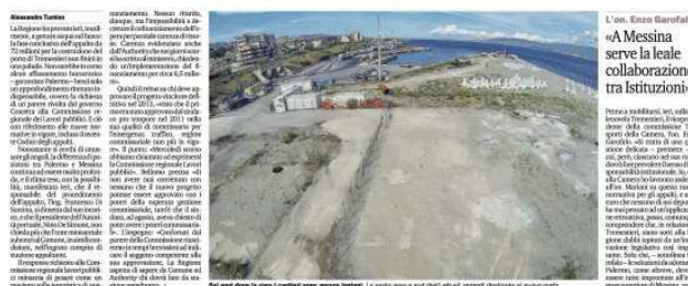
Del mare dopo la gara i cantieri sono ancora lontani. La vista aerea sul porto di Tremestieri mostra la zona di cantiere
