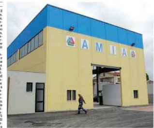
La sede dell'Amia, in viale dell'Industria di Massa Carrara
