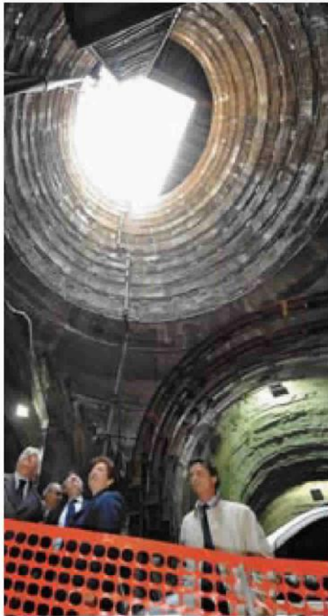
Una fase dei lavori della Linea 1 a Napoli
