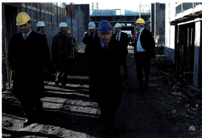
Costruzioni Salvatore Ligresti nel cantiere del porto di Loano in provincia di Savona
