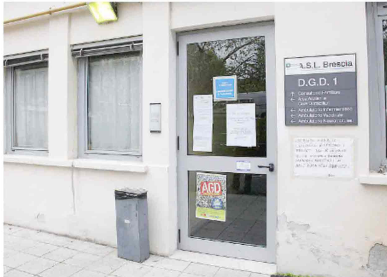
La struttura di via Baracca è stata trasferita nella sede centrale dell'Asl
