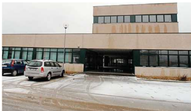
La sede della Peem nella zona industriale di Monselice
