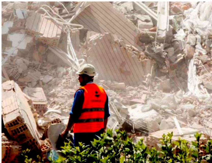
Un uomo della Protezione Civile davanti ai resti di un capannone crollato a Cavezzo nel Modenese, uno dei Comuni emiliani più colpiti dal terribile terremoto di ieri Arcovio, Giubileo, Parrini, Pivato, Rigatelli, Sapegno, Schianchi, Taddia DA PAG. 2 A PAG. 11
