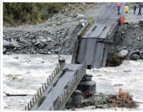
Il ponte crollato in Val Pellice: travolto dalla violenza delle acque, è stato spezzato in due
