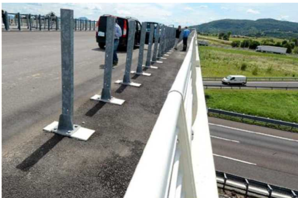
Lavori sul viadotto di Torri di Quartesolo nella Valdastico sud
