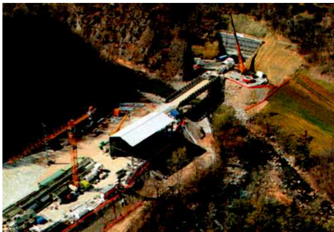
Da sinistra: Mauro Fabris e due viste del cantiere del Brennero. Sotto: Vito Gamberale
