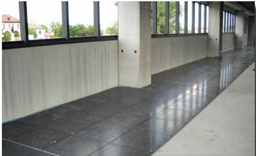
dovevano essere presenti punti passanti di contatto con il sottofondo, che avrebbero costituito dei ponti acustici. Terminato l'intervento di applicazione del sistema isolante MAPESILENT, è stato realizzato un massetto galleggiante autoportante con uno spessore di circa 5 cm con la malta premiscelata a rapido asciugamento e presa normale TOPCEM PRONTO.
