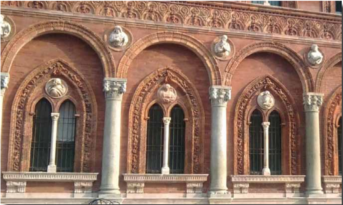
facciata dopo i lavori di restauro
