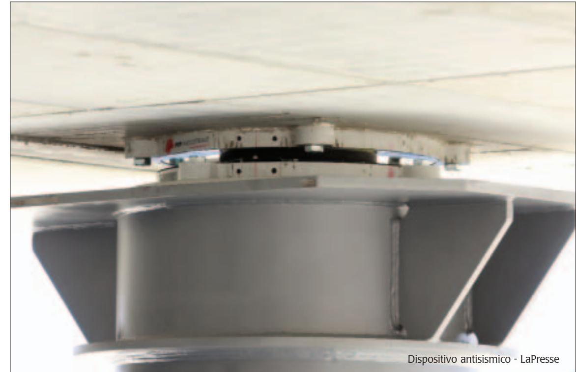
Dispositivo antisismico - LaPresse
